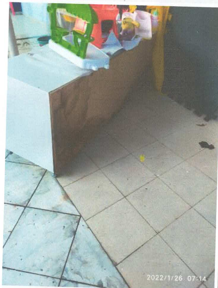
móvel em estado deplorável / retirada
